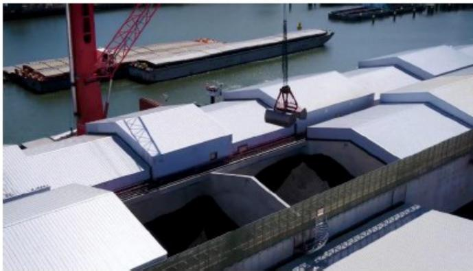
La grúa se sitúa en el cantil, y tiene capacidad para cargar o descargar en el buque o en la nave, en su radio de acción, en una sola maniobra, y sin la necesidad de realizar acopios al suelo, a la intemperie, ni movimientos de material innecesarios.
